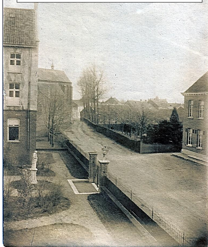
Kerkstraat Panningen. Links het Missiehuis, rechts de open plek waar later de nieuwe kerk gebouwd wordt.
