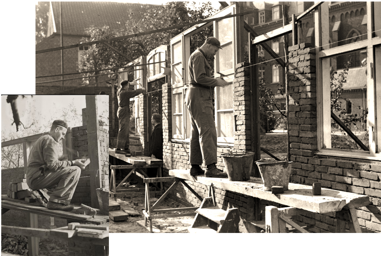
Bouw van de werkplaats door de broeders.
